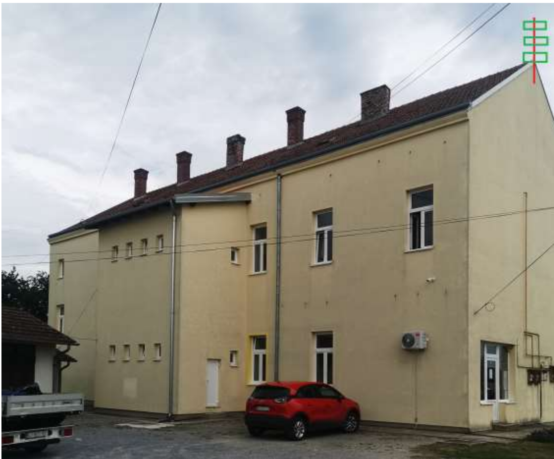
Slika 8: Prijedlog montaže nosača i PTP AP uređaja (gledano sa stražnje strane objekta)
